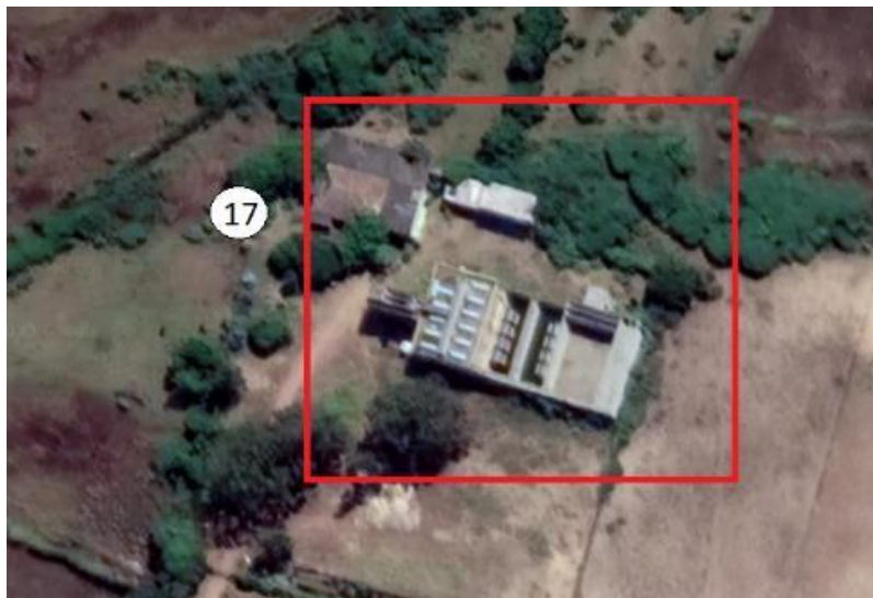
Figura 7.1.2.1 - Vista aérea da localização ETE Matadouro
