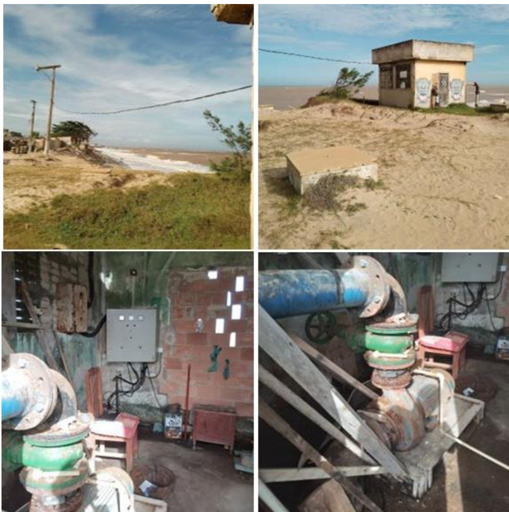
Figura 6.2.2.4 - Situação atual da casa de bombas Reservatório Atafona
