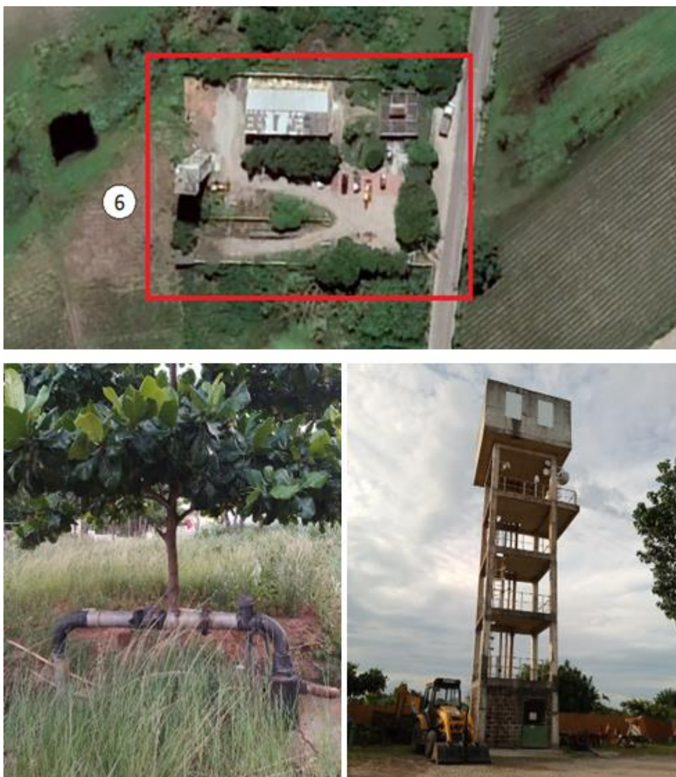
Figura 6.2.7.1 - Poço Sabonete - Localização e Vistoria
