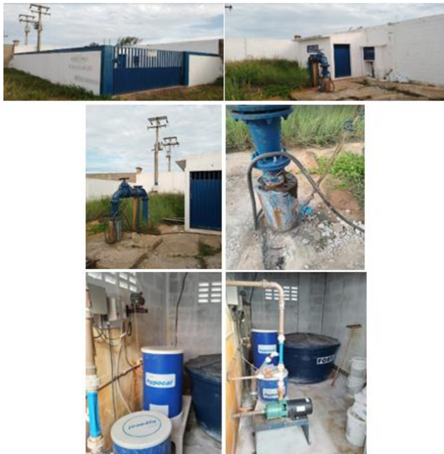
Figura 6.2.2.13 - Poço Parque Exposição - Vistoria
