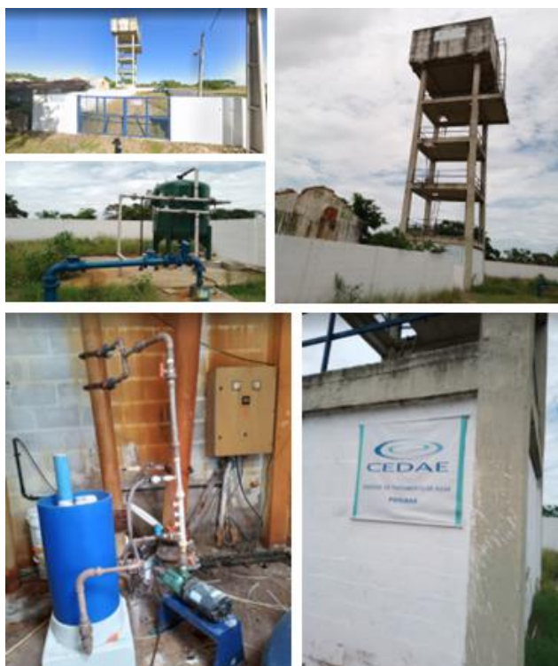
Figura 6.2.5.2 - Poço Pipeira – Vistoria
