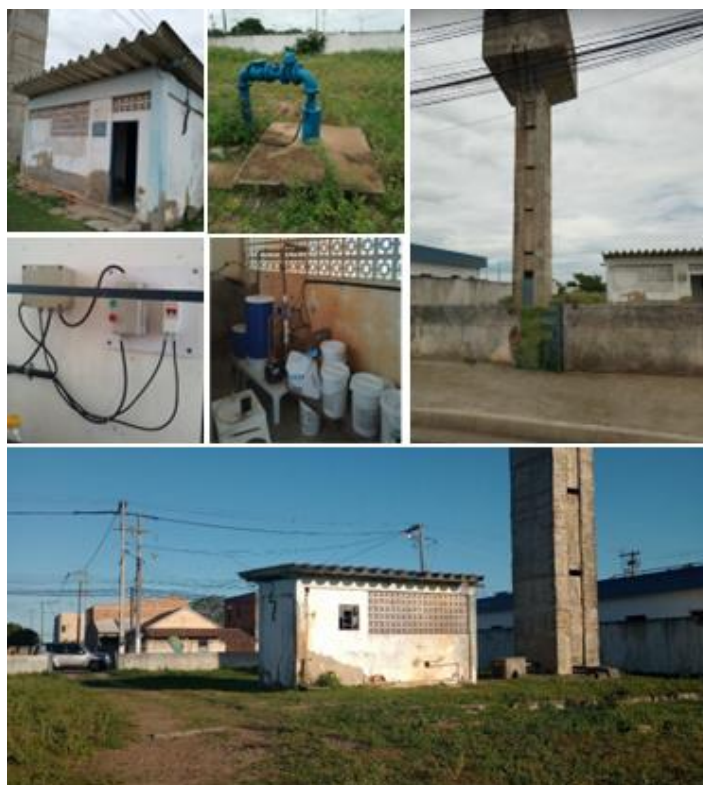
Figura 6.2.4.2 - Poço Barcelos – Vistoria
