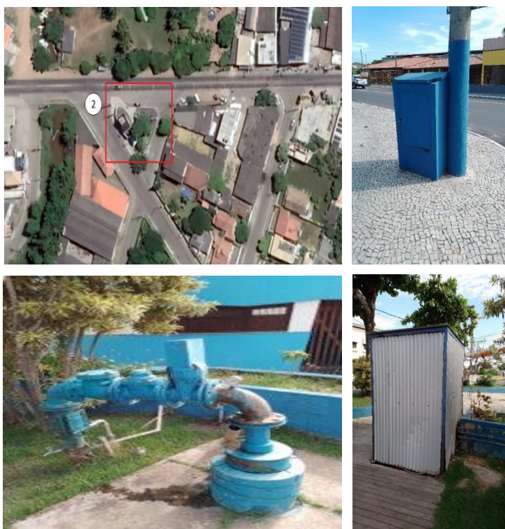
Figura 6.2.2.1 - Poço Atafona – Trevo Jacuí
