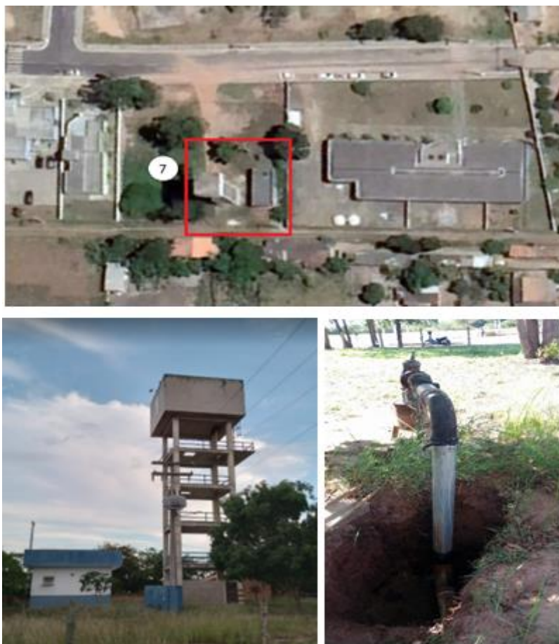
Figura 6.2.8.1 - Poço Mato Escuro - Localização e Vistoria
