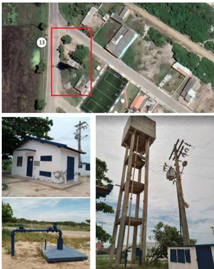
Figura 6.2.6.1 - Poço Açu 1 - Localização e Vistoria
