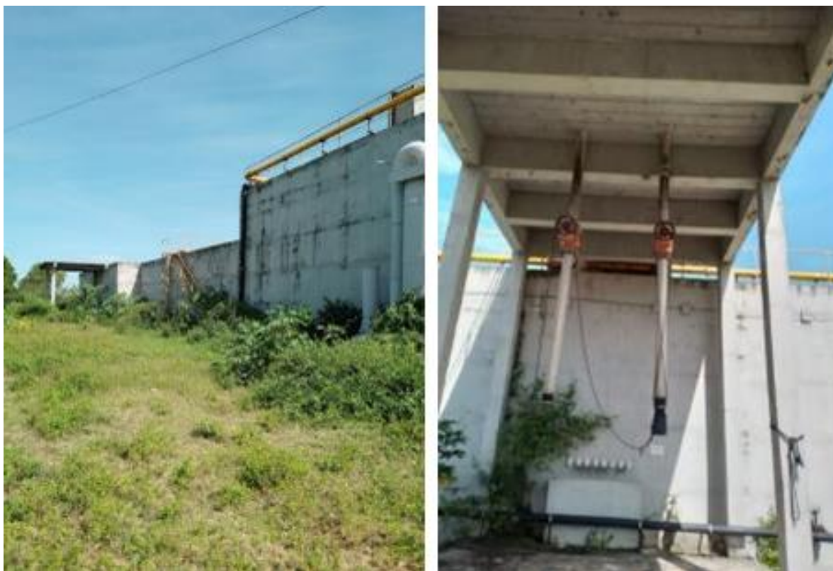
Figura 7.1.2.2 - Vista geral da entrada de esgoto e tratamento preliminar
