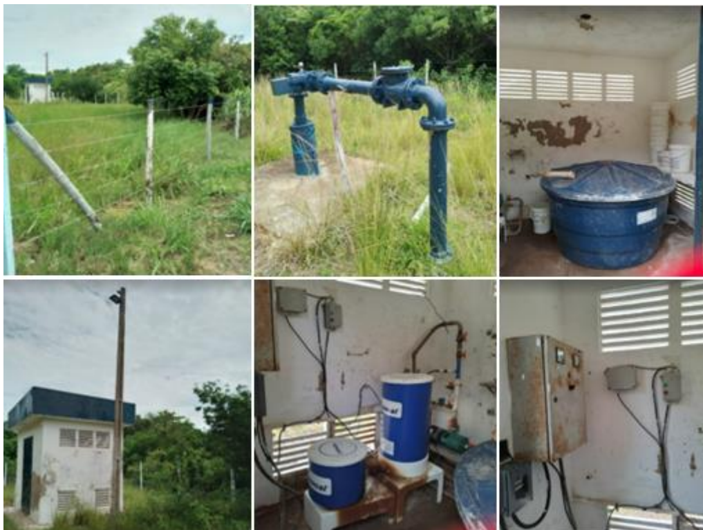
Figura 6.2.2.11 - Poço Curva Grussaí - Vistoria
