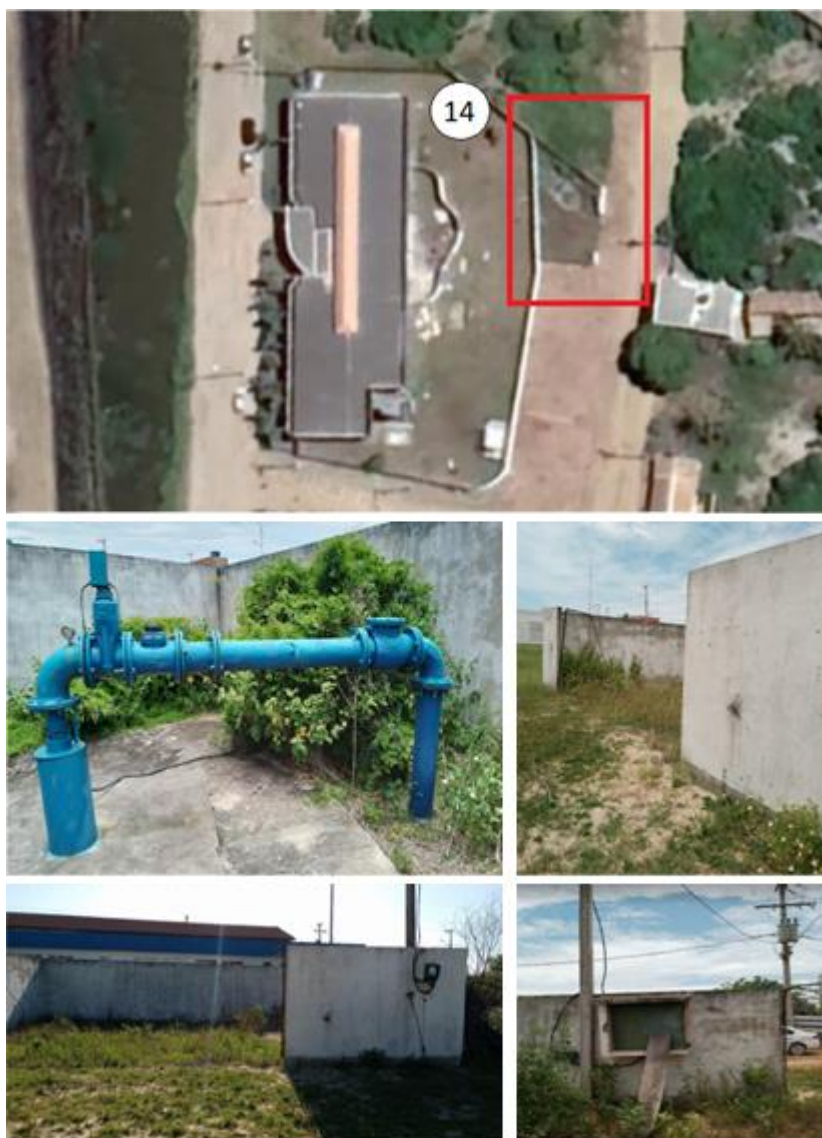
Figura 6.2.6.2 - Poço Açú 2 - Localização e Vistoria
